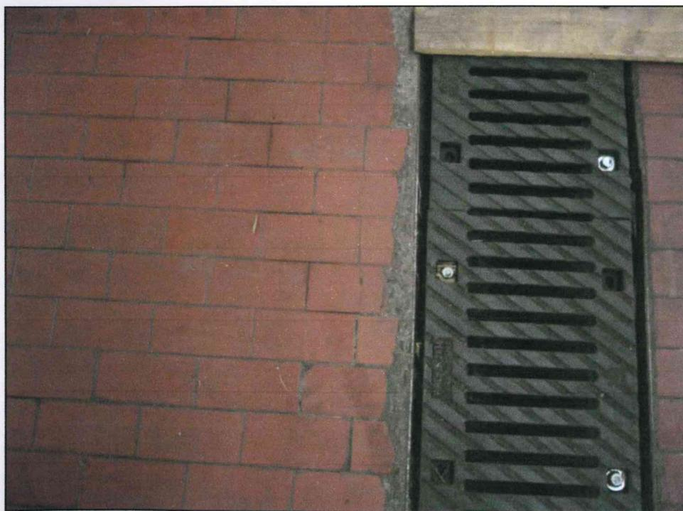
**Fotografia 12 – Particolare Locale Magazzino – Pavimentazione interna e Canaletta**
